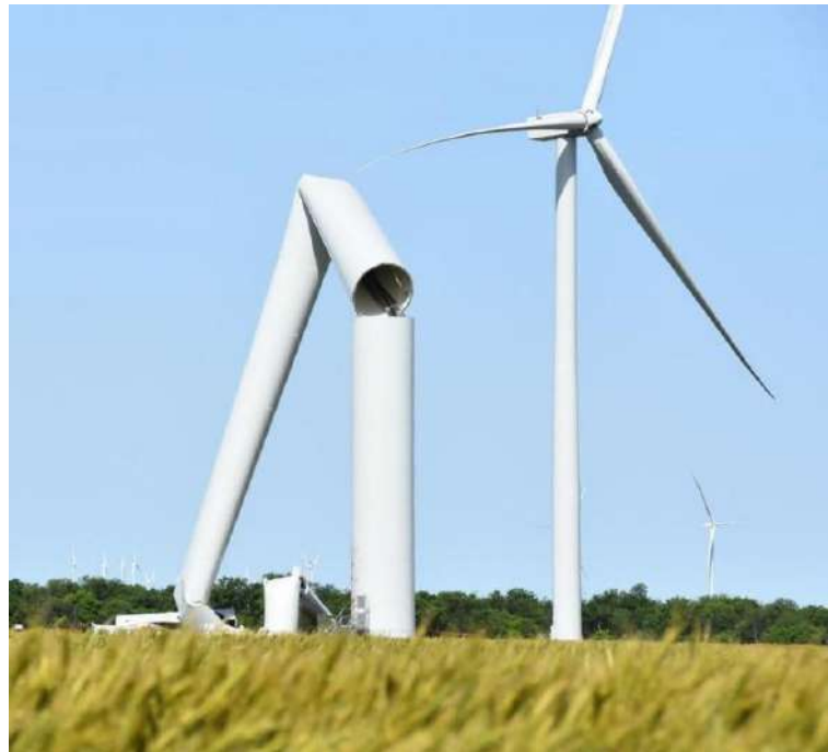
Rys. 1.33. Katastrofa konstrukcji wieży turbiny wiatrowej – materiały PSEW.
